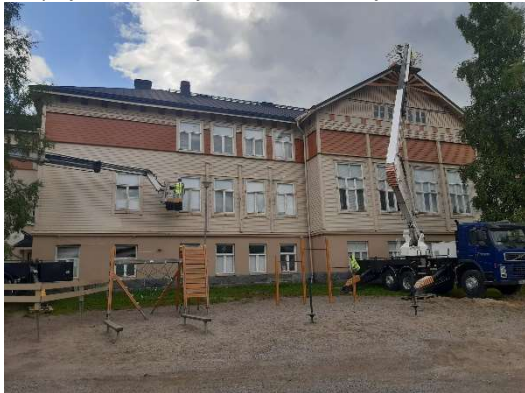
Otavan opiston julkisivun maalaustyöt käynnissä.
